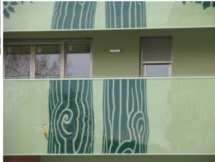
Fachada con detalles
